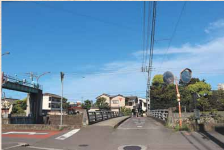
現在の鶏鳴橋
