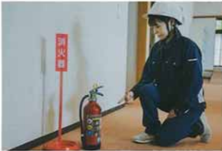
消防設備の保守点検
