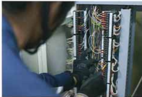
消防設備設置・修繕工事
