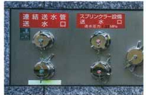
連結送水管耐圧試験
